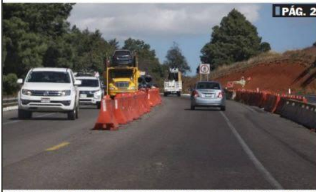
MORELIA, MICH.- Empresarios michoacanos no quitan el dedo del renglón pidiendo la ampliación de la autopista Siglo XXI.
