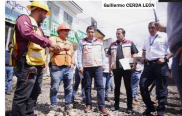
URUAPAN, MICH.- El presidente municipal, Ignacio Campos Equihua, supervisó ayer las obras de modernización de la avenida Francisco Villa y las calles Niños Héroes y Jalisco, las cuales registran importante avance.
