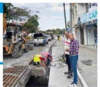
URUAPAN, MICH.- Muchos de los trabajos de la Capasu se refieren al arreglo de fallas en sus redes debido a la antigüedad de las mismas; por ejemplo, ayer fue la rehabilitación de 120 metros lineales de tubería para agua potable, en la avenida Latinoamericana.
