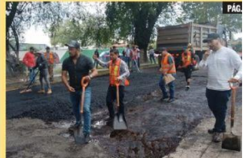
URUAPAN, MICH.- El presidente municipal electo, Carlos Manzo Rodríguez, encabezó nuevamente acciones de bacheo que se realizan con apoyo de empresas particulares.
