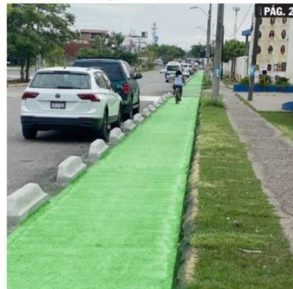
CD. LÁZARO CÁRDENAS, MICH.- Ciclistas han comenzado a hacer uso de un tramo terminado de la ciclovia; algunos comerciantes están obstruyendo la continuación de la obra.
