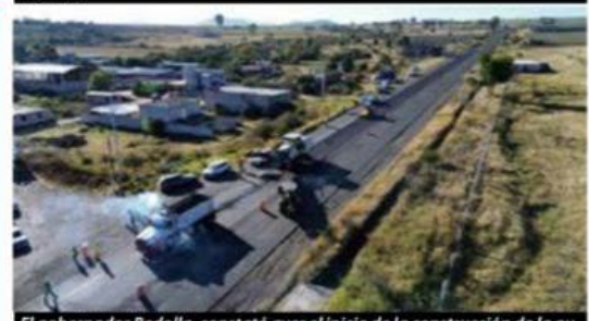
El gobernador Bedolla, constató ayer el inicio de la construcción de la autopista Maravatío-Zitácuaro.
