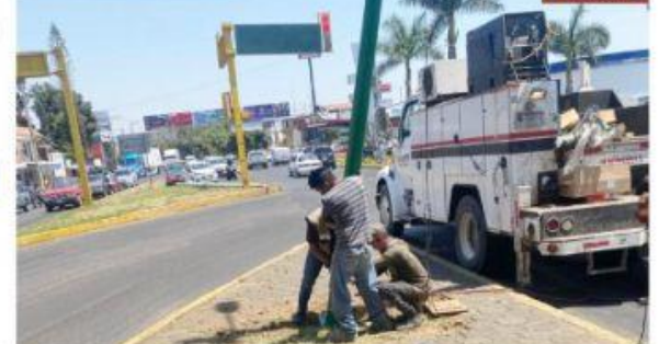
URUAPAN, MICH.- Se comenzaron a instalar ya los últimos 20 de los 85 postes para luminarias led que integrarán la nueva red de alumbrado público de la calzada Benito Juárez.
