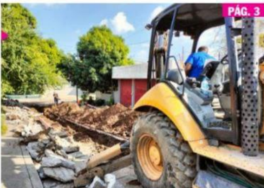
CD. LÁZARO CÁRDENAS, MICH.- La administración municipal realiza obras de vialidad y drenaje en diversos puntos de la ciudad.
