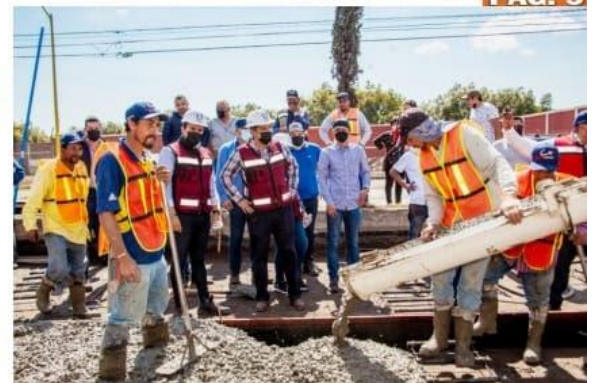
URUAPAN, MICH.- El alcalde, Ignacio Campos Equihua, supervisó los avances que se tienen en las obras del Boulevard Industrial, donde este sábado comenzó a colocarse el concreto hidráulico.
