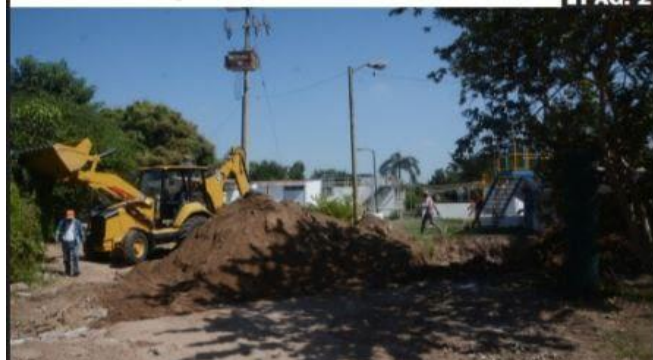
CD. LÁZARO CÁRDENAS, MICH.- La rehabilitación del drenaje del Primer Sector parece estar en su arranque, con las excavaciones que desde este inicio de semana se efectúan en las instalaciones inoperantes de la planta 2 de tratamiento de aguas negras.
