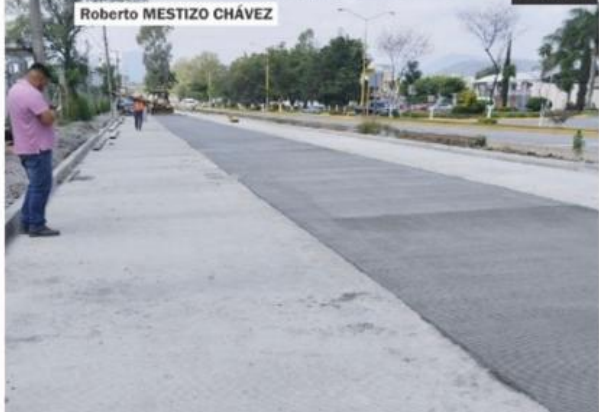
URUAPAN, MICH.- Antes de fin de año pudieran estar concluidos los trabajos que se realizan en la calle Lateral de Boulevard Industrial, que sería la primera vialidad de este municipio que cumpla con las especificaciones que dicta la nueva ley federal de movilidad.
