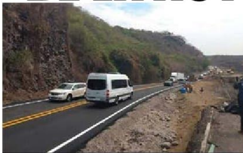
Con la entrada en operación de la planta Laminadora de ArcelorMittal, se prevé mayor saturación de la autopista siglo 21 y por consiguiente mayores riesgos al transitar por ella.
