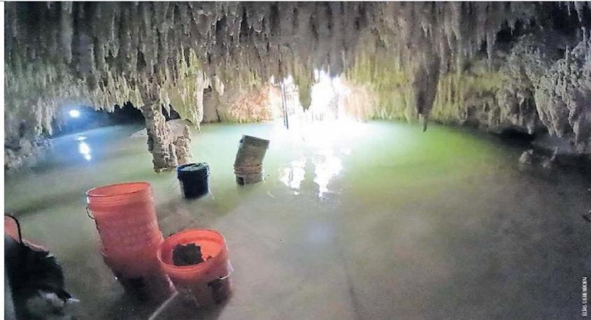
En el informe se detalla que al colocar los pilotes hubo afectaciones en las cavernas sobre las que corre el Tramo 5 Sur, como la caída de cemento en el agua.
