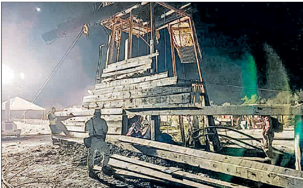
▲ Estructura para la entrada de la mina de carbón Pinabete, ubicada en el municipio de Sabinas. El percance, en el que quedaron atrapados 10 trabajadores, ocurrió cerca de las 13:35 horas a una profundidad de
