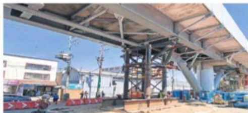
Las 13 mil toneladas de acero se han utilizado para rehabilitar el tramo elevado de la Línea Dorada que colapsó en mayo de 2021.
