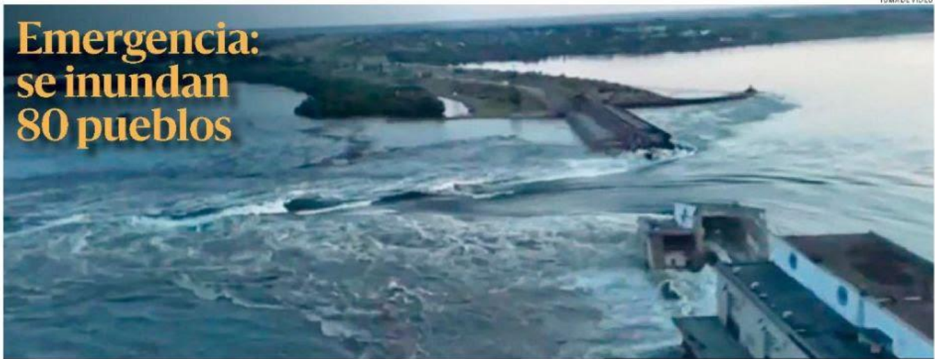
Imagen tomada de video muestra el destruido dique de la presa Kajovka. En total 80 localidades se inundan a lo largo del río Dniéper, cuya orilla izquierda ocupan las tropas rusas y las fuerzas ucranianas la ribera derecha.
