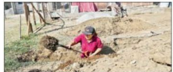
▲ Cargar tabiques o bultos de cemento no fue obstáculo para que María Santos desempeñe un oficio que ama: la albañilería. Foto Luis Castillo
