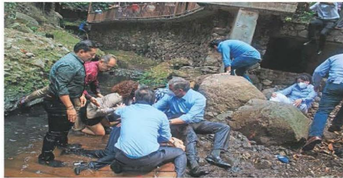
Cuernavaca.— El alcalde José Luis Urióstegu y 20 personas de su comitiva resultaron lesionados por el desplome del puente colgante en el Paseo Ribereño. La estructura fue rehabilitada el año pasado con 20 mil pesos, al quedar fuera del presupuesto para mejoras. | ESTADOS | A18
