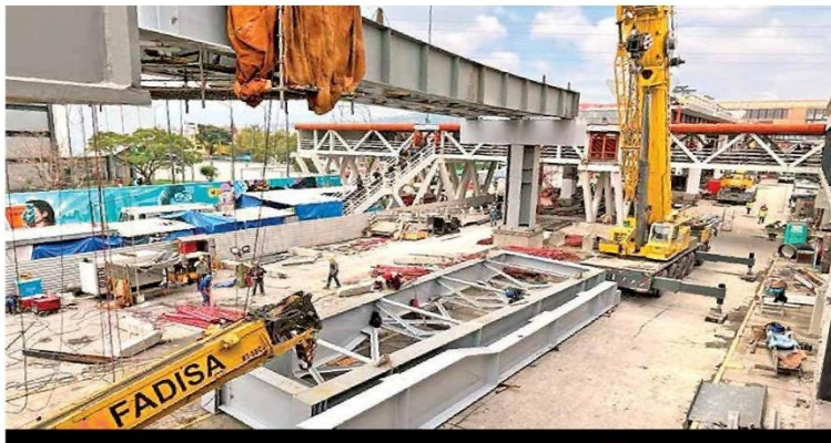
COMUNIDAD ALCALDÍA IZTAPALAPA APURAN OBRAS PARA EL TROLEBÚS ELEVADO A cuatro días del inicio de pruebas operativas para el nuevo sistema de transporte, trabajadores laboran para terminar de colocar traves de acero, color losas, retirar andamios y tender el cable de alimentación. / 18
