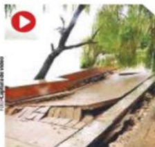
DAÑOS en la obra de Tepetitán, en Tabasco.
