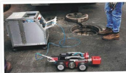
UN VEHÍCULO con cámara recorre la tubería del pozo contaminado.
