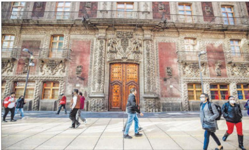
▲ El Palacio de Iturbide, joya arquitectónica del barroco construida entre 1779 y 1785 para los condes de Moncada y los marqueses del Jarat de Berrio, ubicado en la calle de Madero, en el Centro Histórico, forma parte del acervo cultural que se incluye en la venta de
