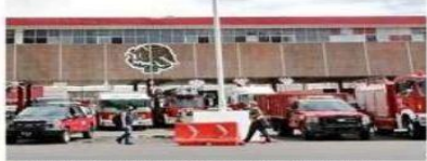
La zona de dormitorios de los bomberos en la Estación Central, tiene daños estructurales desde el 19S.
