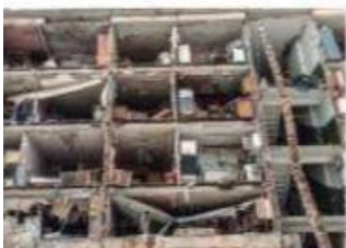
DESTRUCCIÓN en un edificio de departamentos en Járkov, Ucrania, ayer.
