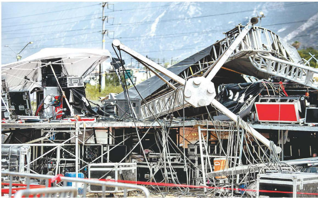
Escombros del escenario que se fue a tierra por una tormenta eléctrica y un vendaval en San Pedro Garza García. MIGUEL SIERRA/EFE
