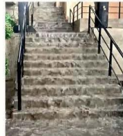
Vecinos han documentado el caudal de agua pluvial sobre el andador.
