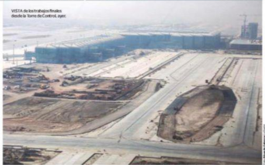
VISTA de los trabajos finales desde la Torre de Control, ayec. AIFA. A 18% DE CONCLUIR OBRAS; TERMINARÁN A TIEMPO, ASEGURAN A MENOS de 90 días de inaugurar la terminal aérea sólo falta colocar los sistemas de la Torre de Control, instalar bandas de equipaje y mostradores, explica capitán primero constructor. pág. 8
