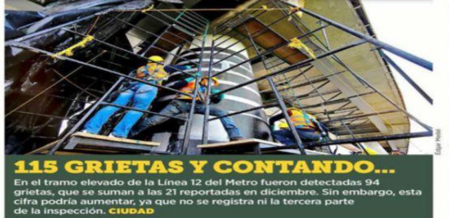
115 grietas y contando... En el tramo elevado de la Línea 12 del Metro fueron detectadas 94 grietas, que se suman a las 21 reportadas en diciembre. Sin embargo, esta cifra podría aumentar, ya que no se registra ni la tercera parte de la inspección. CIUDAD
