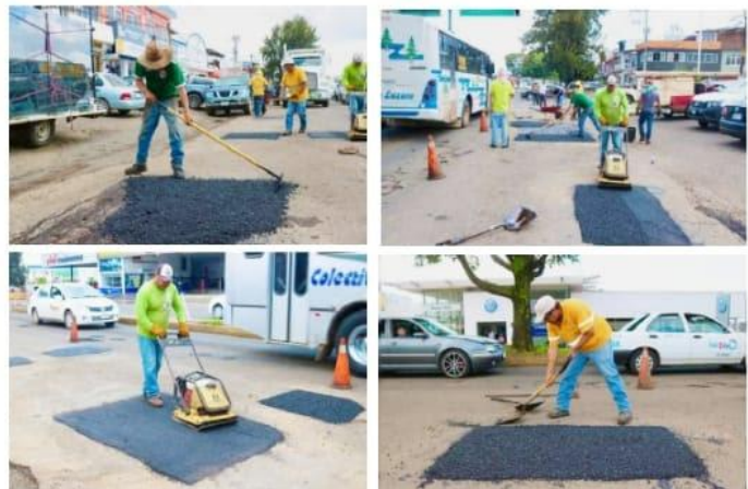
URUAPAN, MICH.- El tramo más dañado de la calzada B. Juárez será pavimentado con concreto hidráulico con recursos por casi 12 mdp, que ya gestionó el alcalde, Ignacio Campos, reveló él mismo.
