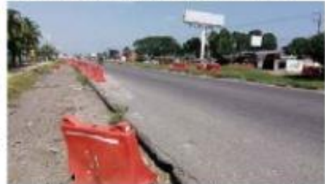
Para la CMIC es urgente que se reinicie y concluya por supuesto, la obra del Distribuidor Vial, para mejorar la infraestructura urbana de la ciudad.
