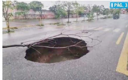
CD. LÁZARO CÁRDENAS, MICH.- Para poder atender los socavones y daños que presentan las vialidades de la ciudad, el ayuntamiento de Lázaro Cárdenas ha tenido que pedir "fiada" la tubería, informó la alcaldesa, Itze Camacho.
