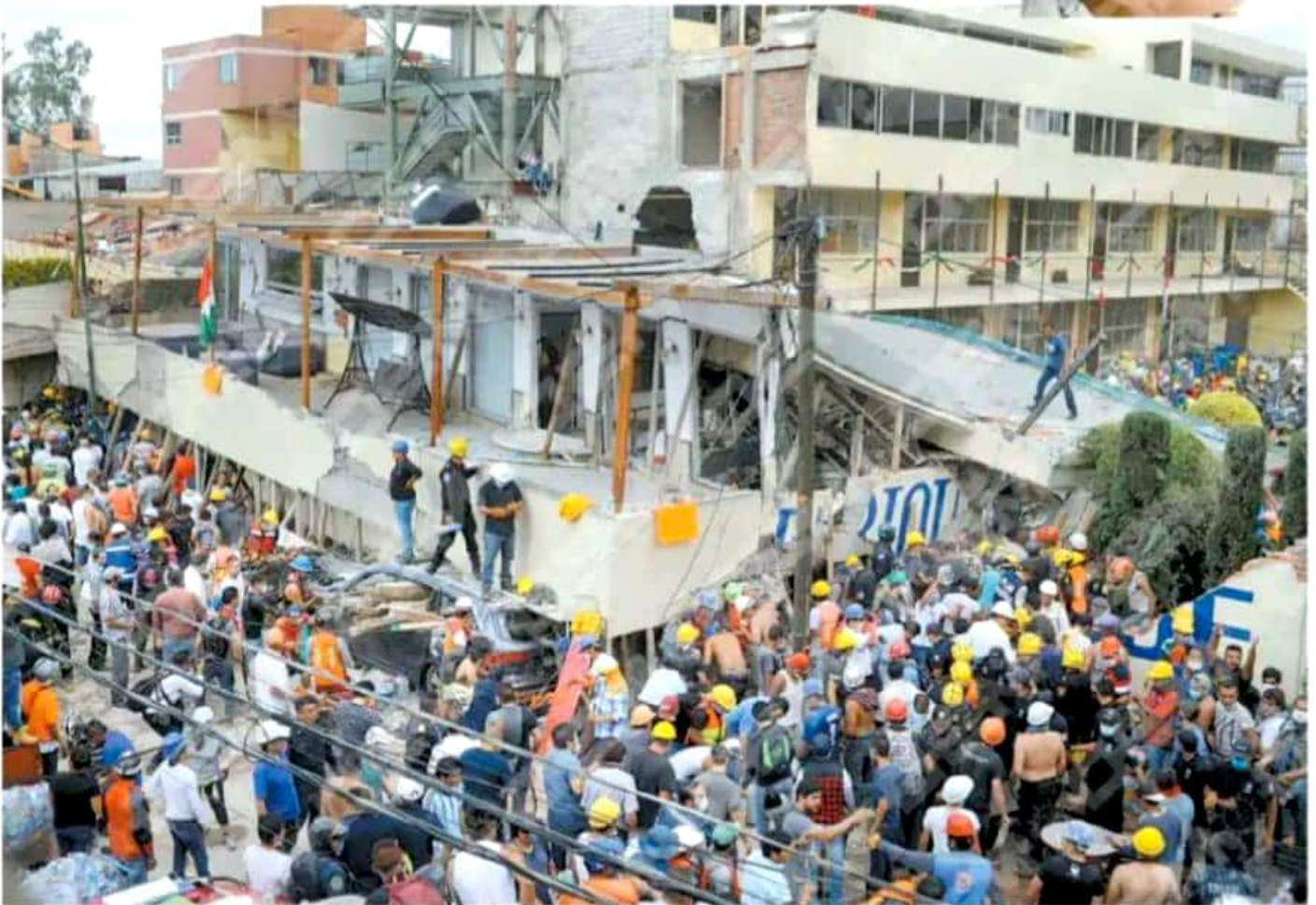
La mujer debe responder por la muerte de 26 personas, al desplomarse el plantel educativo durante el sismo de 2017 por presuntas irregularidades en su construcción. FOTO: ANILCO MARTÍNEZ
