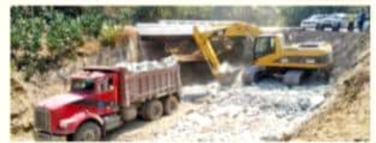
CD. LÁZARO CÁRDENAS, MICH.- PCM reconoció y agradeció el apoyo brindado por la empresa ArcelorMittal para la limpieza y desazolve de canales de la tenencia de La Mira y comunidades aledañas.
