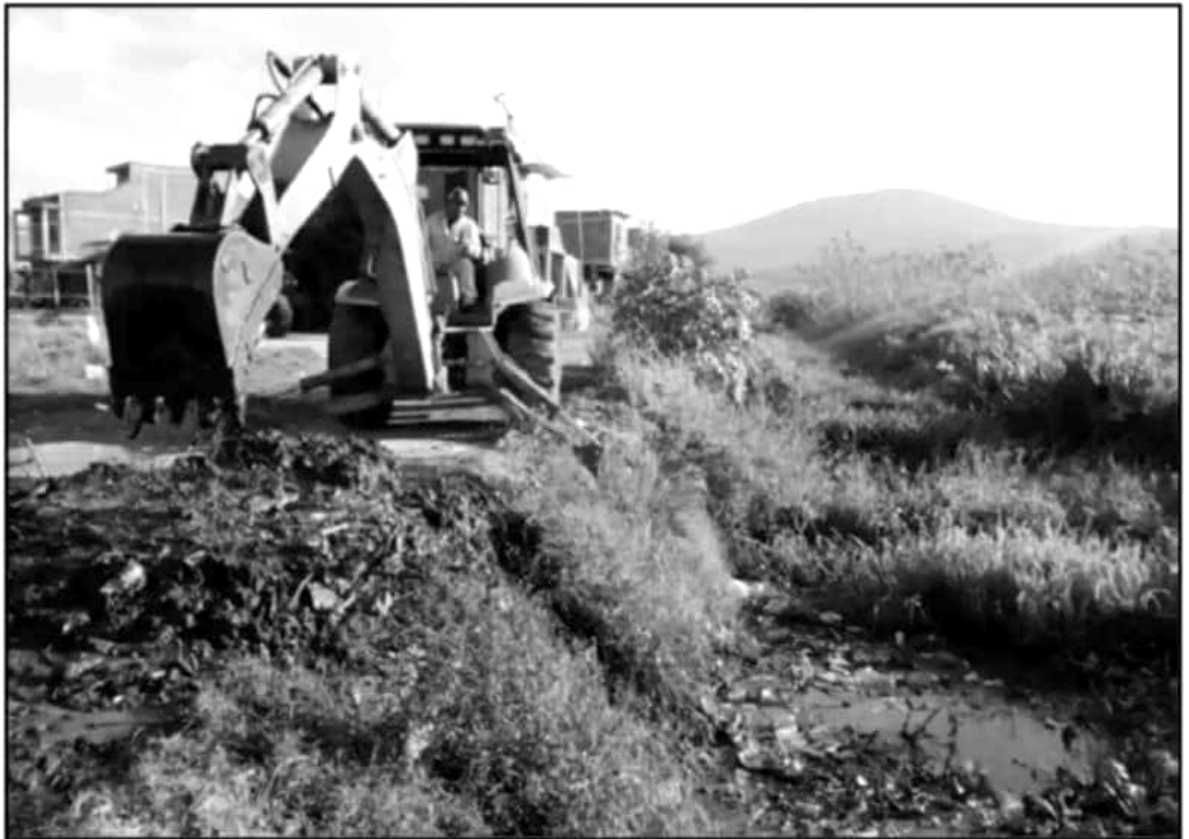
EN YURÉCUARO, LA SCOP COORDINÓ LABORES DE DESAZOLVE ANTE LA RECIENTE SUBIDA DEL NIVEL EN EL CANAL DE RIEGO POR LAS RECIENTES TORMENTAS
