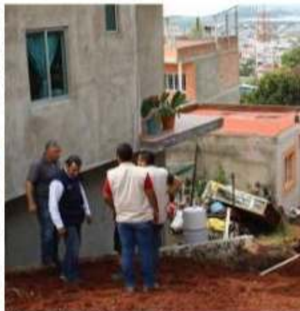
LOS REYES, MICH.- Positivo avance registra la pavimentación de la prolongación de Felipe Ángeles.
