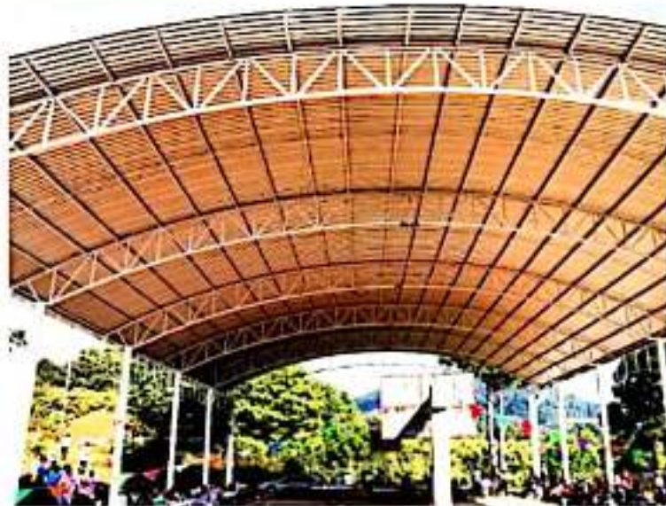
LOS REYES, MICH.- Se inauguró el techado de la cancha de la escuela primaria de la comunidad de Cheratillo.
