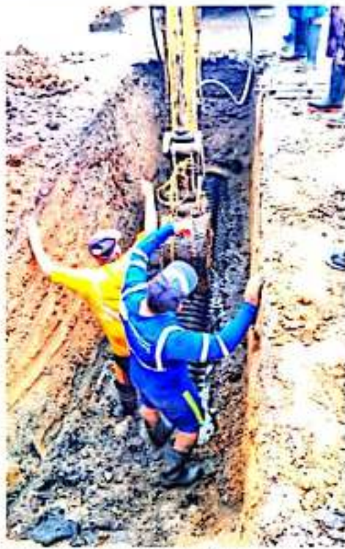
CD. LÁZARO CÁRDENAS, MICH.- El Capalac lleva a cabo la reparación de tres socavones que se formaron en la avenida Ejército Mexicano.
