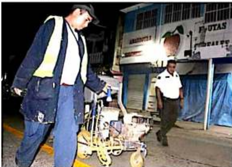
CD. LÁZARO CÁRDENAS, MICH.- Personal de Tránsito y Vialidad de Lázaro Cárdenas apoyados con elementos de Ingeniería Vial de Morelia realizaron trabajos de señalamientos en las inmediaciones del mercado Cuauhtémoc.
