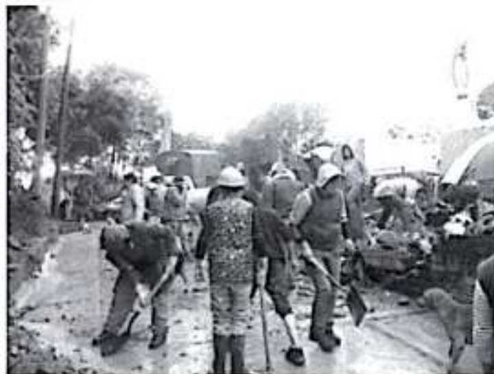
Se reportó la caída de una de las bandas perimetrales del Parque Municipal, por lo que se tuvieron que evacuar dos domicilios para resguardar la integridad de los habitantes.
