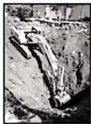
EL CAPASU TRABAJA EN LOS SISTEMAS DEL DRENAJE DE URUAPAN
