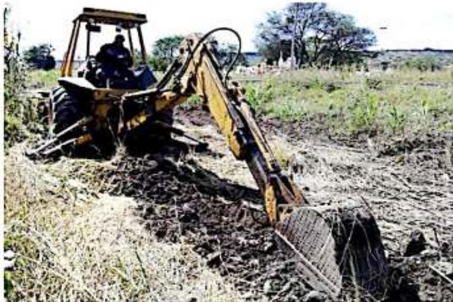
ZAMORA, MICH.- Con algunas precipitaciones pluviales atípicas, en las inmediaciones de la comunidad, El Sauz de Arriba, la Dirección de Obras Públicas trabaja en la apertura de alrededor de 150 metros lineales de zanja, para la conducción de aguas pluviales.
