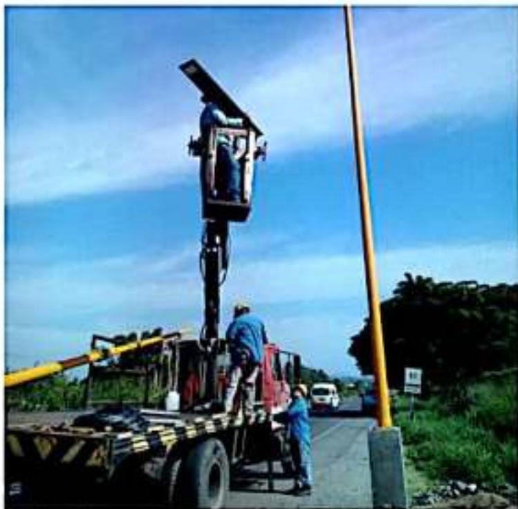
CD. LÁZARO CÁRDENAS, MICH.- Fueron colocadas por el departamento de Alumbrado Público las primeras cuatro de 10 lámparas previstas para la calle Prolongación Morelos.
