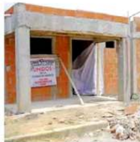
La vivienda inicia a reconstruirse en un asentamiento y zonas de bajos y familias afectadas. (CERRILLO)
