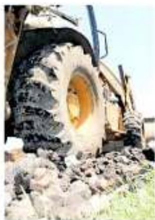
Las obras forman parte del Programa de Regeneración Vial
