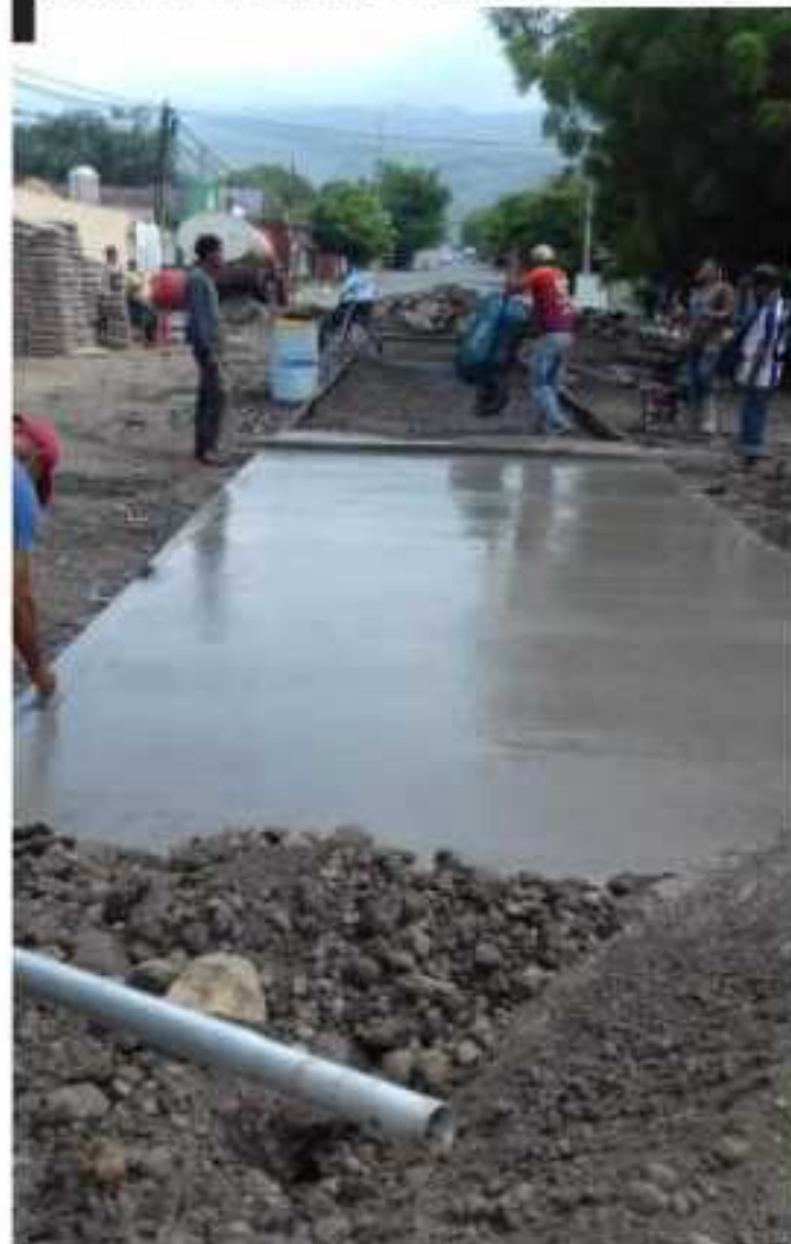
APATZINGÁN, MICH.- La pavimentación de la avenida Constitución de 1814, vía principal de la ciudad, registra un importante avance, informó Juan Carlos Sánchez Pardo, titular de la Secretaría de Obras Públicas.
