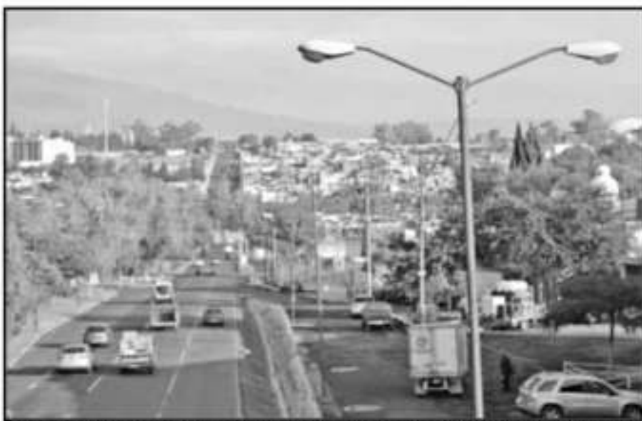
MEDIANTE LAS MULTAS, EL AYUNTAMIENTO PRETENDE REDUCIR EL DESEMPEÑO PARA REPARAR INFRAESTRUCTURA.
