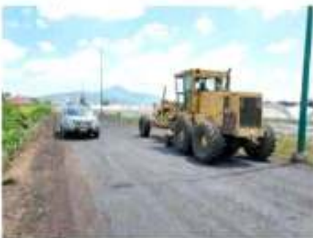
ZAMORA, MICH.- Trabajos de bacheo y re-nivelación se realizan en la calle Luis Hernández Barrera, anteriormente conocida como Par Vial Juárez.
