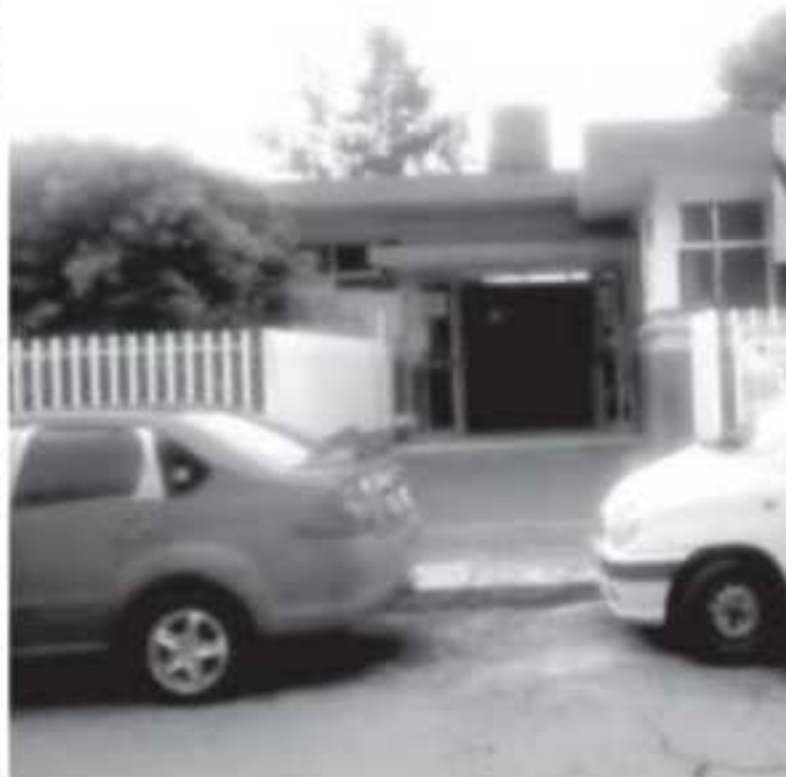
Consultorios y otras áreas se reubicarán temporalmente en término de construcción podría ser de siete meses.
