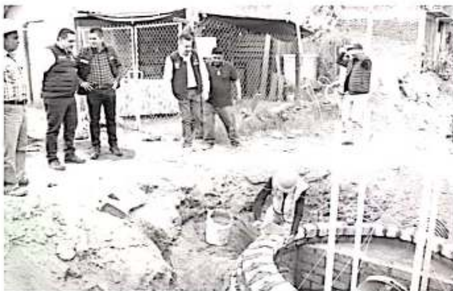
No obstante, en el asentamiento se ejerce una inversión de casi 12.5 millones de pesos para construir un colector pluvial.
