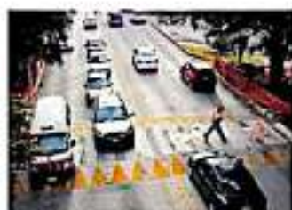
La construcción de esta obra está justo enfrente del IMSS. Mariana Urua
