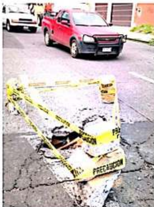
URUAPAN, MICH.- Nuevamente vecinos de la calle Michoacán reportaron el enésimo hundimiento de un tramo de concreto en el cruce de dicha vialidad con la calle Guerrero.
