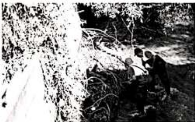
URUAPAN, MICH.- Se trata de un ambicioso proyecto de la Comisión de Agua Potable, Alcantarillado y Saneamiento de Uruapan (Capasu), cuyo objetivo principal es el de evitar que las aguas negras sigan contaminando el río Cupatitzio.
