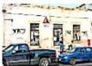
En el Centro hay varios casos de casas en mal estado. JACOB HERRERA
