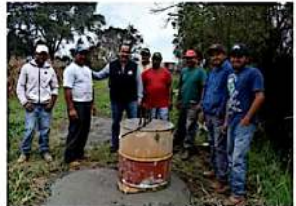
En el arranque de la obra del tanque elevado con los trabajadores de la obra.
